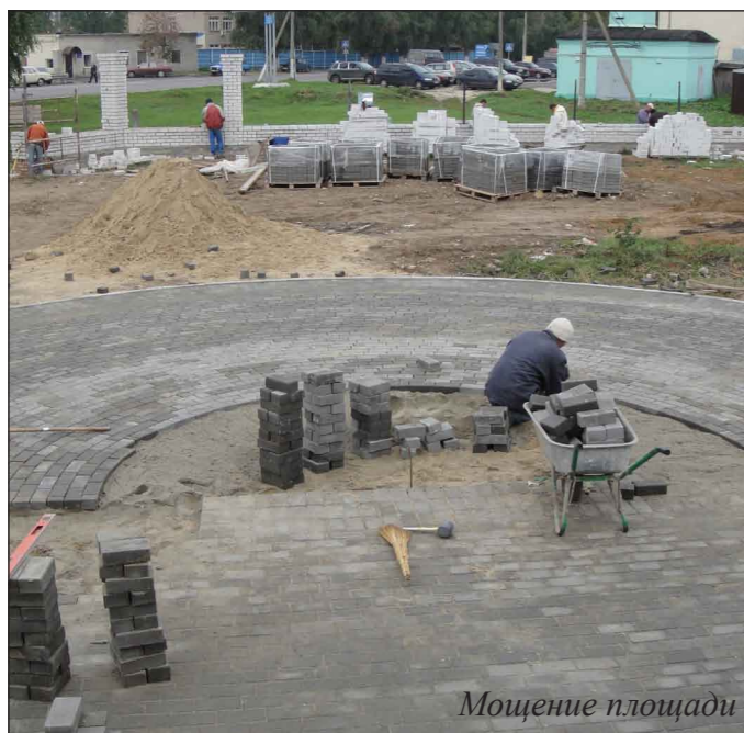
Укладка каменных плит
