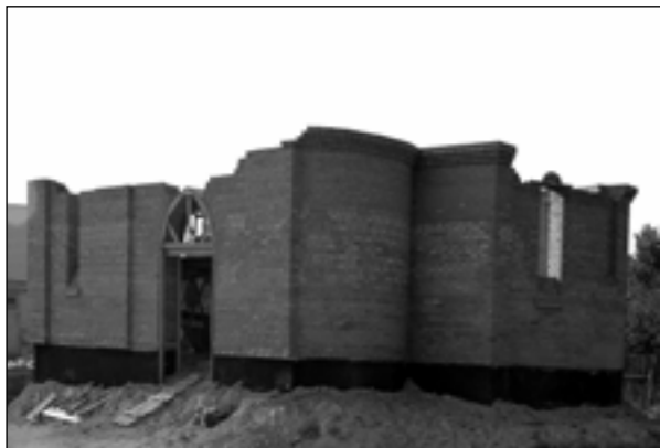
Возведение стен храма 2005 г.
